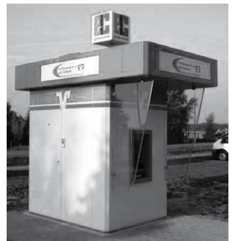
Geldausgabeautomat in Bargeshagen
