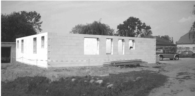
Die Seitenwände des neuen Sportlerheimes stehen schon, bald kann die Decke gegossen werden
